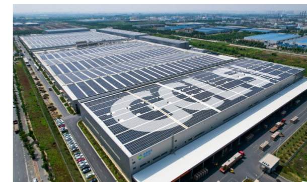
合肥协鑫鑫昱光伏电站
