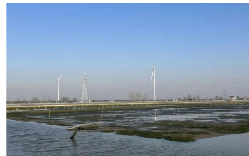
江苏阜宁协鑫 30MW 风电项目
