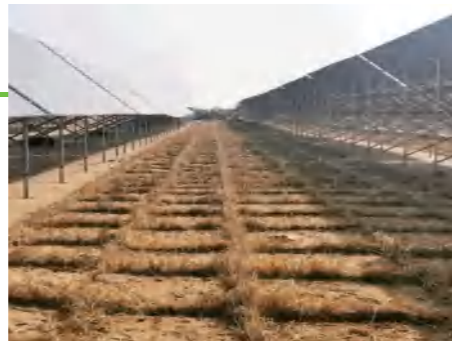
2020年12月12日并网的榆林协鑫科榆阳小壕免费当采明村100MW光伏平价项目——耳林光伏电站
